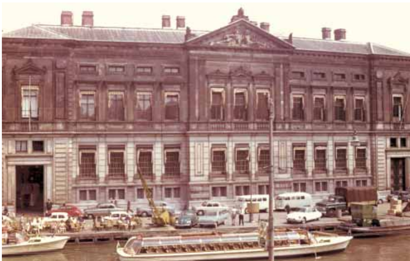
Het pand van DNB aan de Oude Turfmarkt. DNB was vanaf de beginjaren (1814) op deze locatie gevestigd, maar betrok in 1869 dit pand van architect W.A. Froger. In 1967 verhuisde DNB naar de huidige locatie aan het Frederiksplein.
